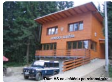
Dům HS na Ještědu po rekonstrukci
